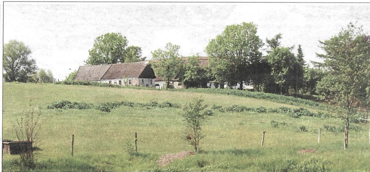
Den ældste del af den fredede Mortenstruppgård har ligget i Usserød Ådal siden 1750.
